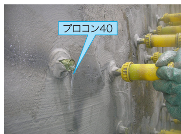
プロコン40先行注入の状況
