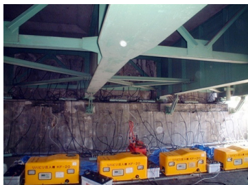
橋台のASR補修事例
