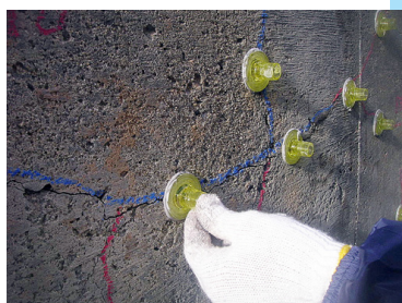
座金設置状況
