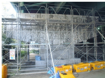
橋脚(はり部)のASR補修事例
