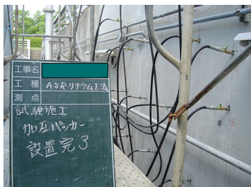
擁壁のASR補修事例
